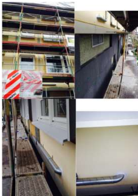
Figur 4 Bilder på kanaldragning från byggtiden.
