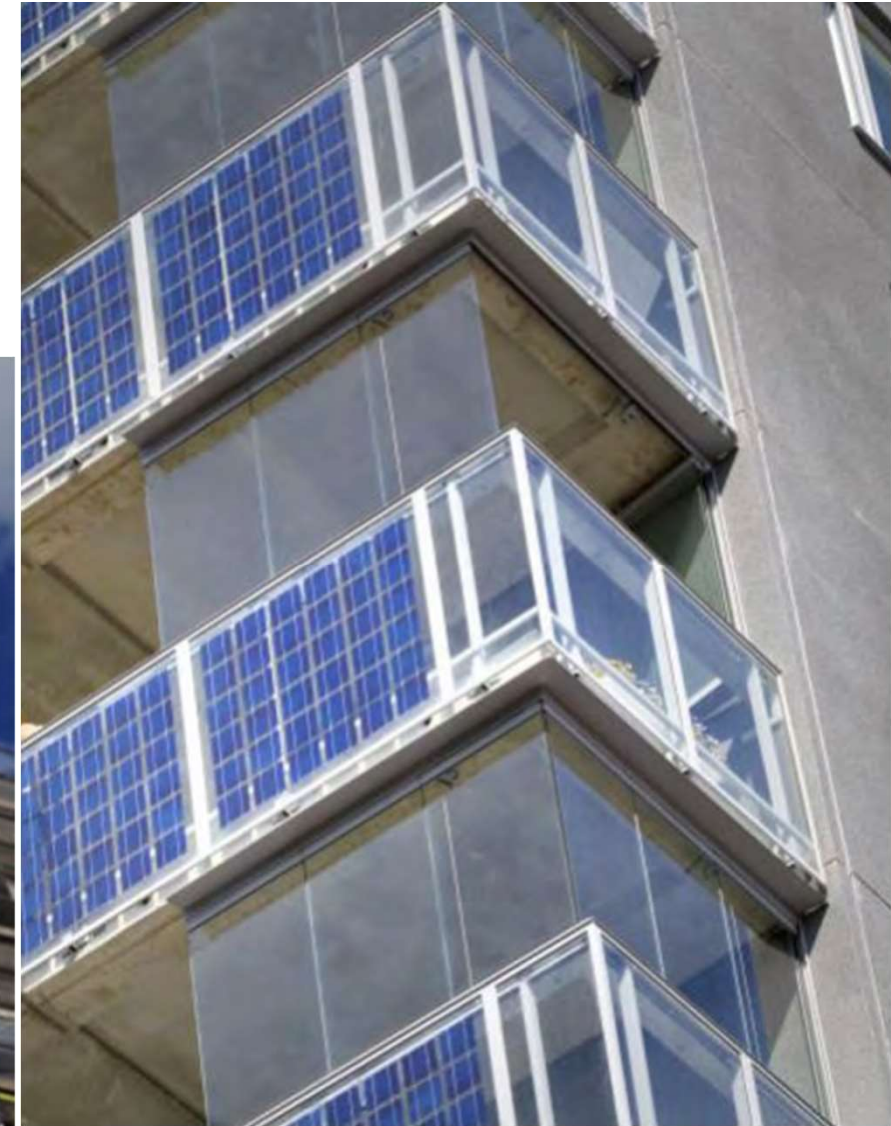
Solcellspaneler installerade som balkongräcke på Fullriggaren, Gävle. Bildkälla: Gefle Dagblad.
