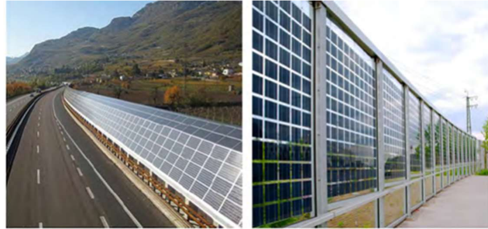
Solcellspaneler som bullerplank Uppsala universitet/ÅF infrastructure 2018.
