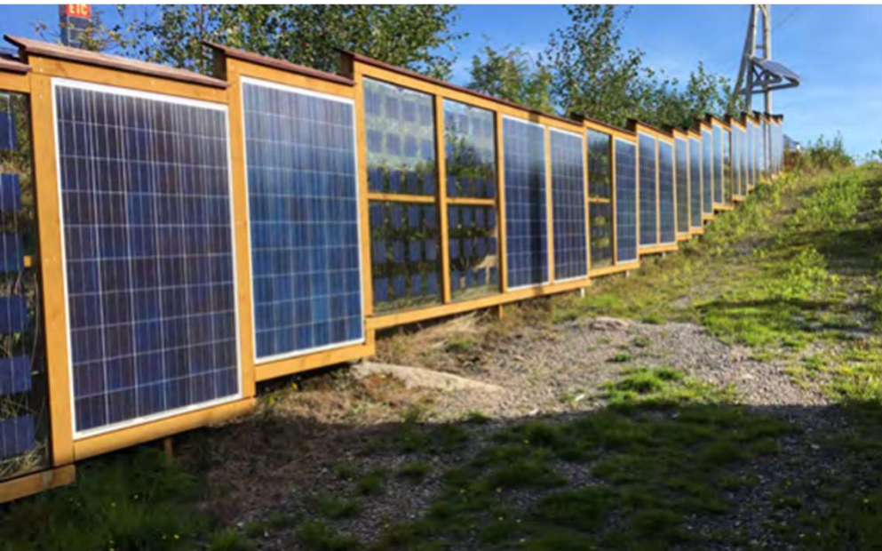
Solcellspaneler som staket/bullerplank i Katrineholm. Bild: Sanna Nilsson, WSP
