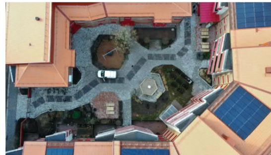
Vid Nedre Holländaregatan 24-28 på söder i Helsingborg, finns en av Helsingborgshems solcellsanläggningar.
