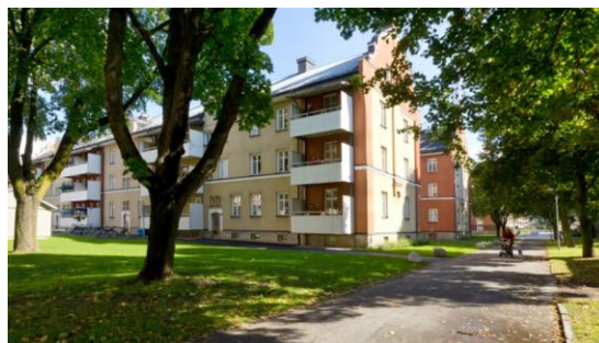
Fastigheten Melonen, en av byggnaderna där tekniken har installerats
