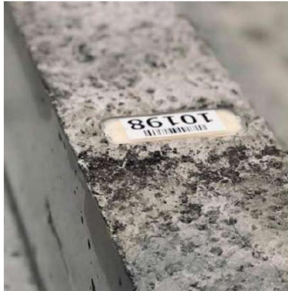
Figur 1: Radiofrekvensidentifierings-chip (RFID) i ett betongelement för "Circle House Demonstrator". RFID-chippet är ansluten till materialpassen som innehåller information om byggnadsdelen, till exempel materialinnehåll i betongen och dess hållbarhet. (Jensen & Sommer, 2018)
