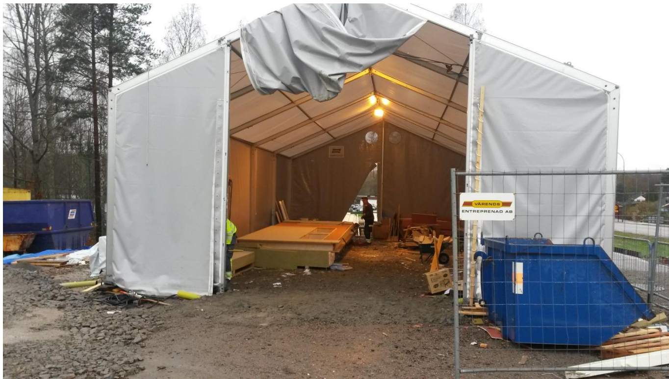
Fasadelement byggda på plats
