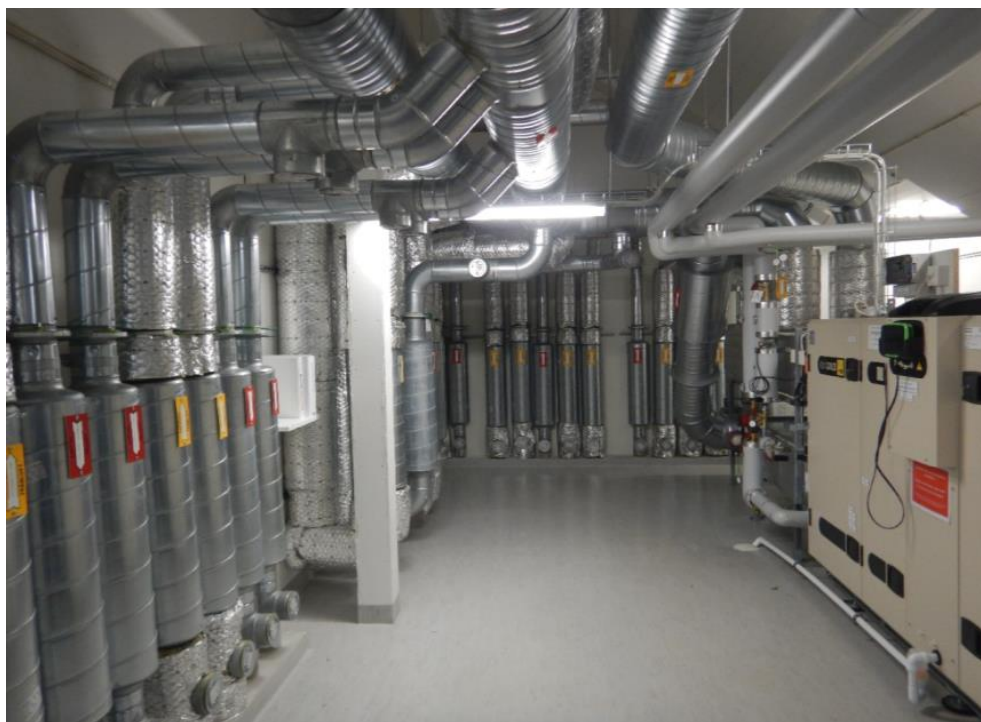
Figur 12 Bilden av fläktrum hos Vätterhem. Bilden kommer från tävlingshandlingarna för Svensk Ventilation och BeBos Tekniktävling ventilation del B, som handlar om att få till bättre funktioner och kontroll på fördelning av luftflöden till och från respektive lägenhet.
