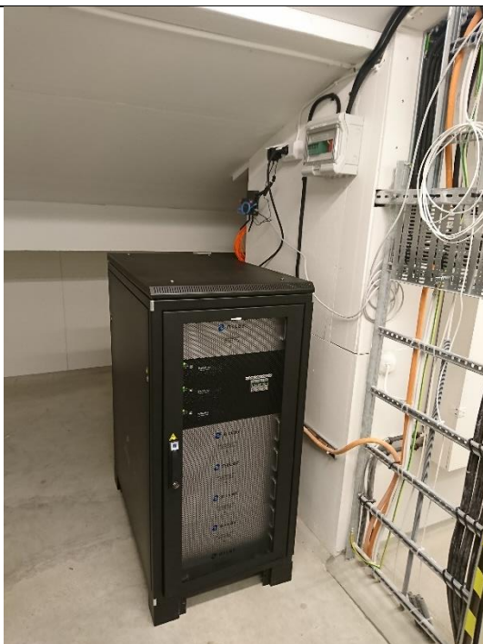
Batterilager 16,4 kWh.
