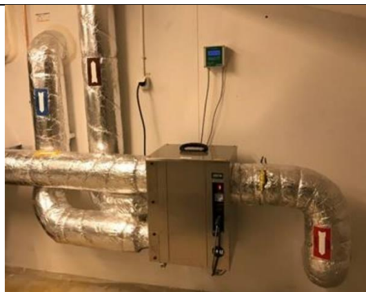
25 Avfuktare DC-20 DST samt styrenhet EH3/T2
