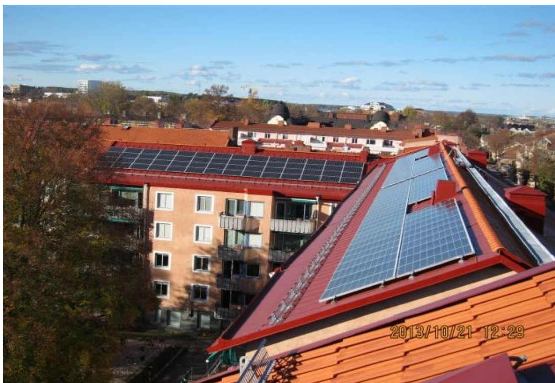
Figur 23: Solcellsanläggningen på BRF Granegården. Foto: Jan Lemming.
