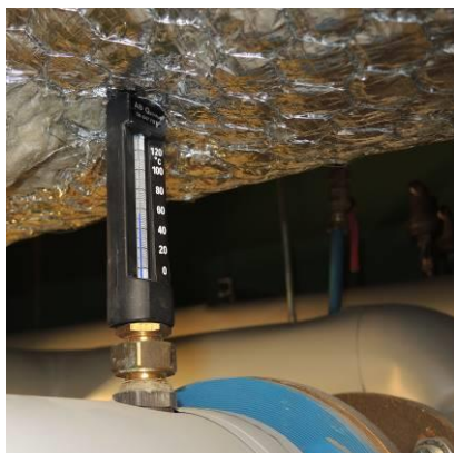
Bild 5. Termometer i varmvattenkrets är inte demonterbar varför dykrör inte kan nyttjas vid TA Scope-mätning.
