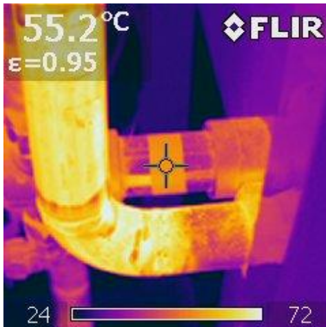
Bild 3. Temperatur på VV uppmättes momentant till 55,2°C vid besöket.
