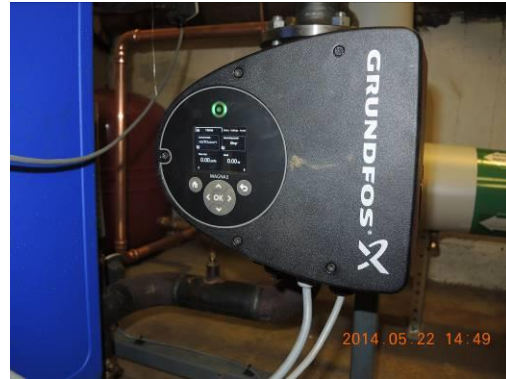
Bild 2 Värmecirkulationspump (i läge stopp vid besöket)
