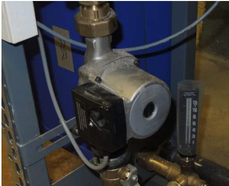
Bild 1. VVC-pump har märkeffekt 55-71 W.
