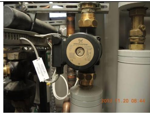
Bild 2.2. VVC-pump. Märkeffekt 135-240W
