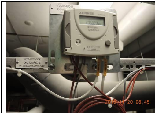
Bild 2.1. Värmemängdsmätare, VVC.
