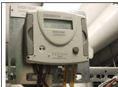
Bild 2.2. Enligt värmemängdsmätare för VVC uppgick VVC-förlusterna till 166 MWh för år 2013, motsvarande 166000/13205=12,6 kWh/m 2 ,år.
