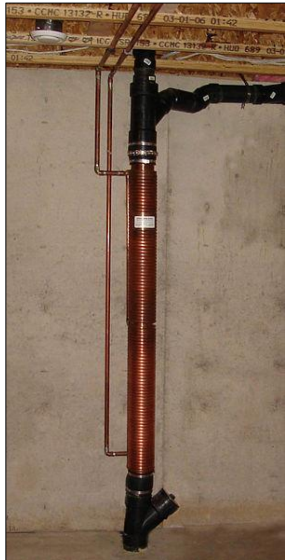
Figur 2.3 – Installation av stående rörvärmeväxlare i källare för förvärmning av tappkallvatten och/eller tappvarmvatten
