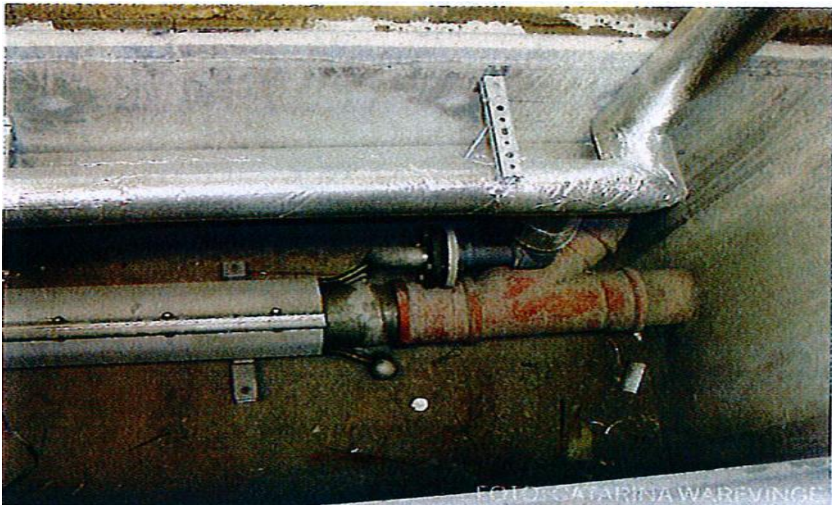
Figur 2.1 – Typisk installation av liggande rörvärmeväxlare
