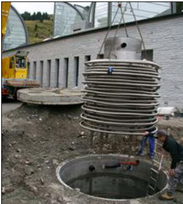
Figur 2.6 – Nedsänkning av värmeväxlare i brunn
