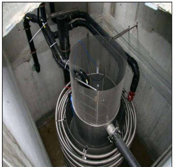
Figur 2.7 – Värmeväxlare nedsänkt i brunn och inkopplad till vatten- och avloppssystem
