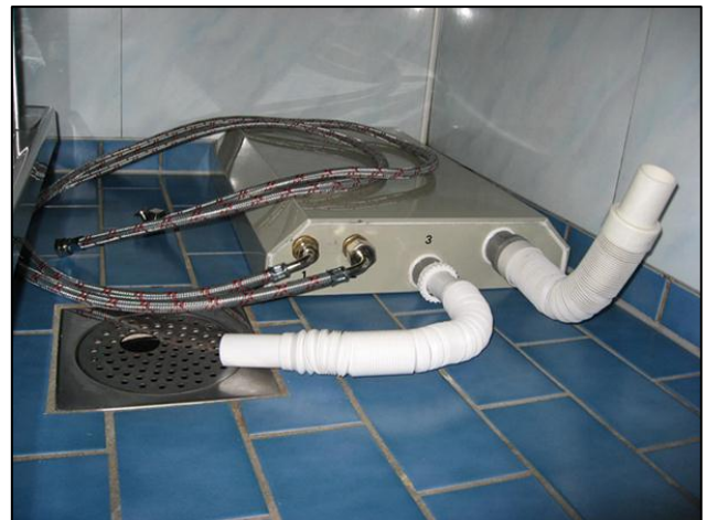
Figur 2.5 – Typisk duschvärmeväxlare som fristående enhet.
