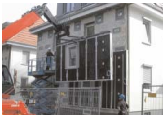
Figur 56. Upphängning av elementen. Källa: http://praxisberichte.eu/hp894/GEDT-Grosselement-Daemmtechnik.htm
