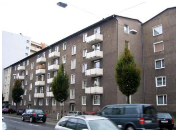
Figur 46. Före renovering. Källa: Gap-solution.
