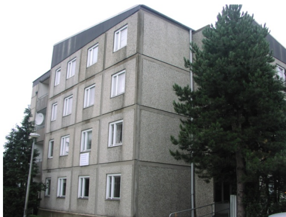
Figur 59 Katjas gata 119 i Backa, före ombyggnad. Källa foto: SP.
