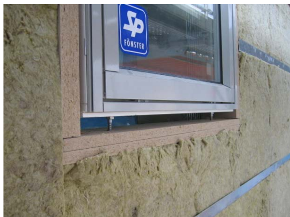
Figur 66 Tilläggsisolerad fasad och nya fönster utifrån sett. Källa foto: SP.
