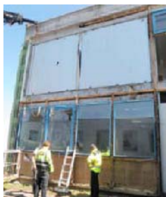
Figur 26. Montage av element, det inre elementet är på plats och det yttre ska monteras. Källa IEA ECBCS Annex 50.
