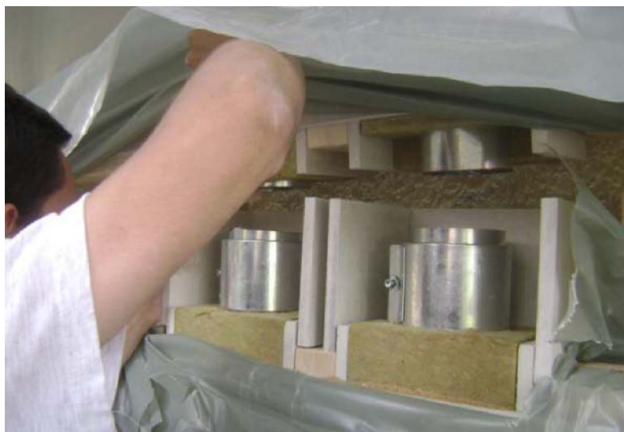
Figur 35. Inpassning av ventilationskanaler vid montage av element. Källa: IEA ECBCS Annex 50.
