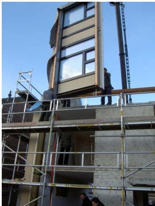
Figur 40. Montage av prefabricerade fasadelement. Källa: Aramis Alleewonen.
