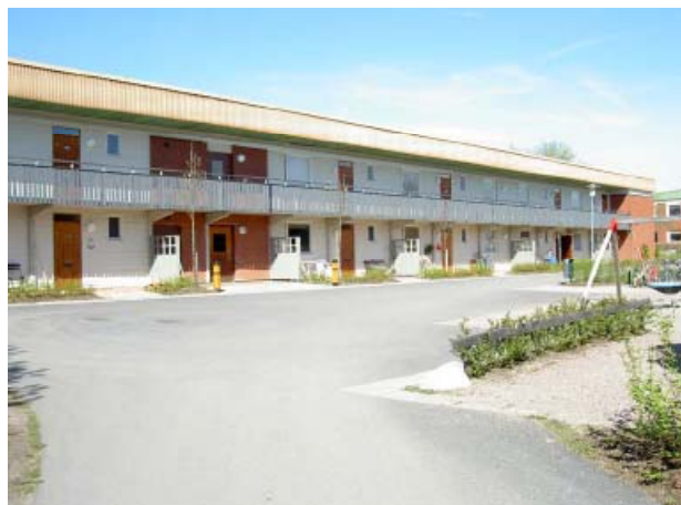
Figur 70 Norrbacka före renovering.
