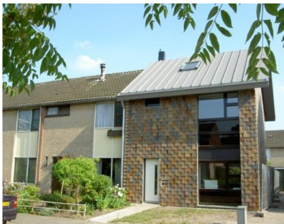
Figur 37. Ett försökshus med prefabricerade fasadelement och takelement av trästomme med cellulosaisolering. Till vänster syns även det icke renoverade grannhuset. Källa: Aramis Alleewonen.
