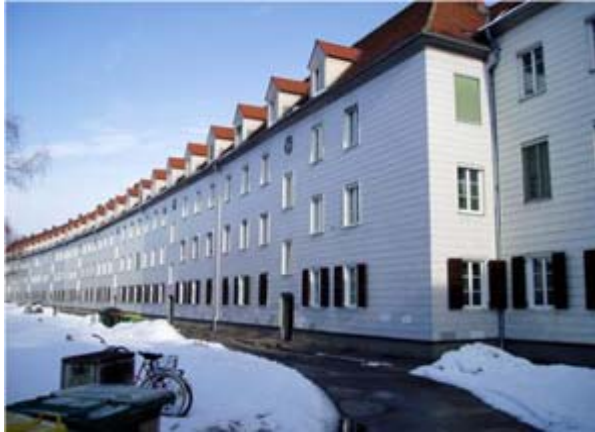
Figur 48. Före renovering. Källa: Gap-solution.
