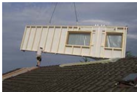
Figur 31. Montering av prefab- elementen. Källa: IEA ECBCS Annex 50.
