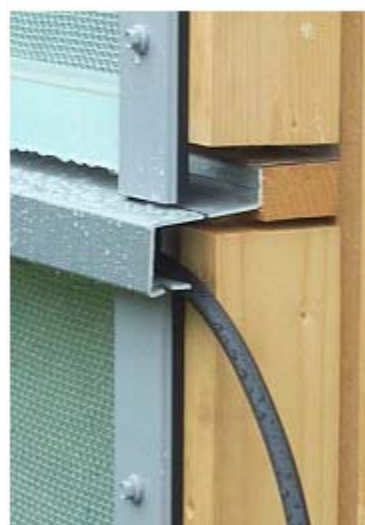
Figur 42. Panelen vid montage. Källa: Gap-solution.
