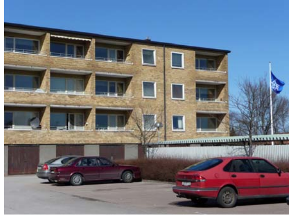
Figur 9 Lamellhus i Halmstad före ombyggnad.
