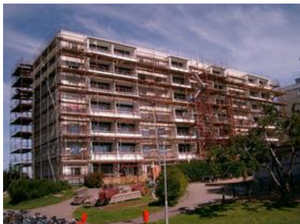
Figur 68 Orrholmen under fasadrenovering. Källa: www.KBAB.se .
