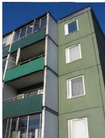
Figur 74 Fasad före renovering. Källa: IVL Cerbof rapport.
