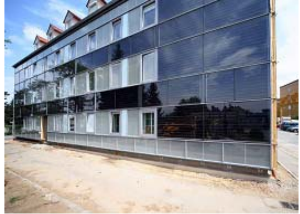
Figur 49. Efter renovering. Källa: Gap-solution.
