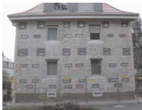
Figur 55. Upphängningspunkter på den befintliga väggen. Källa: http://praxisberichte.eu/hp894/GEDT-Grosselement-Daemmtechnik.htm
