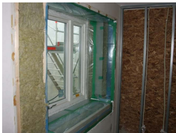
Figur 67 Tilläggsisolerad fasad och fönster inifrån sett, Brogården. Källa foto: SP.
