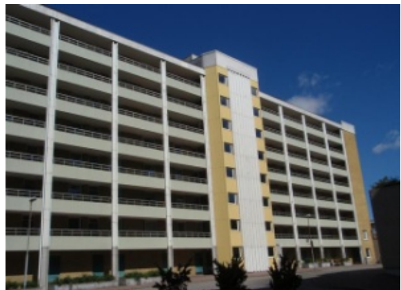
Figur 11 Skivhus i Majorna, Göteborg, byggt 1972:
