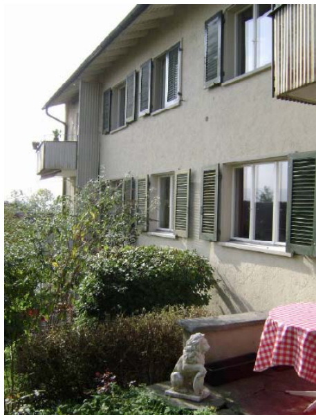
Figur 28. Före renovering. Källa: IEA ECBCS Annex 50.
