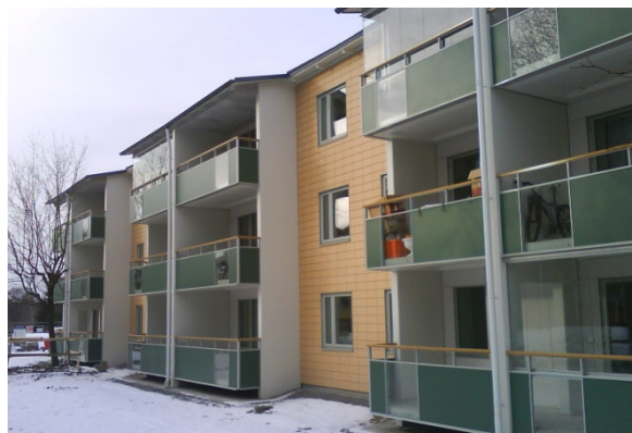
Figur 65 Fasad på Brogården efter renovering. Källa foto: SP.
