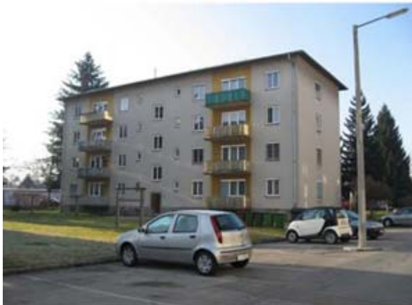
Figur 50. Före renovering (hus 4, 6, 8).
