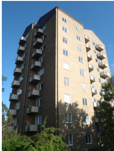
Figur 4 Punkthus på Guldheden, Göteborg byggt 1950.
