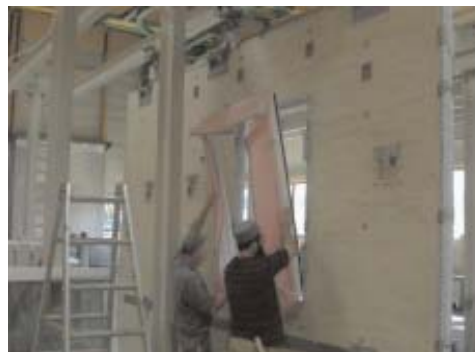
Figur 53. Montage av fönster i ett färdigt element. Källa: http://praxisberichte.eu/hp894/GEDT-Grosselement-Daemmtechnik.htm
