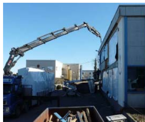
Figur 27. Montage av ett yttrelement med kran. Källa IEA ECBCS Annex 50.
