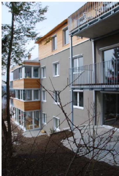
Figur 29. Efter renovering. Sadeltaket är byggt om till en uthyrbar våning och hörnet har byggt till med vardagsrum och nya balkonger. Källa: IEA ECBCS Annex 50.
