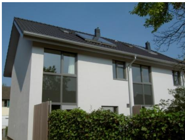
Figur 36. Två försökshus med renoveringskoncept bestående av tilläggsisolering med EPS isolering och puts på fasad och prefabricerade takelement i trä med cellulosaisolering. Källa: Aramis Alleewonen.
