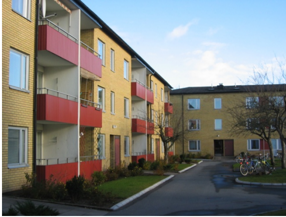
Figur 8 Lamellhus i Brogården före ombyggnad.
