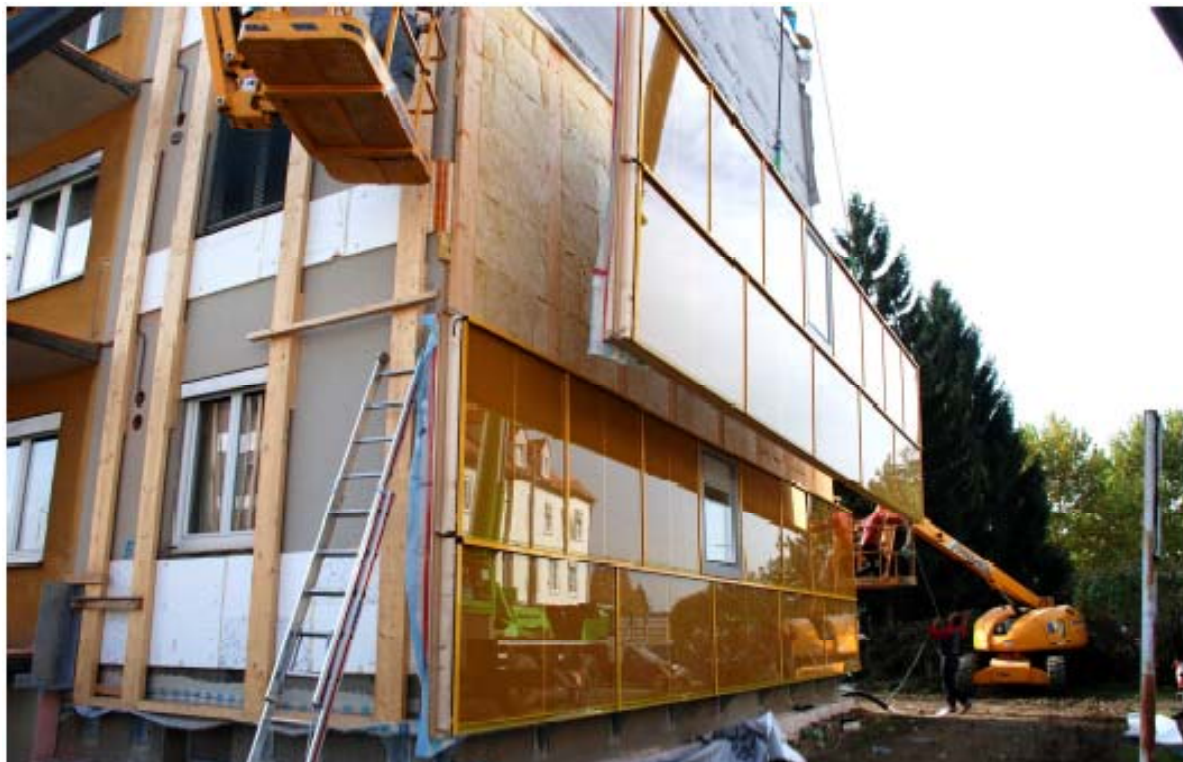
Figur 45. Montage av elementen. Gap-panelerna monterade på träregelementen lyfts på plats av en kran och fästs på den bakomliggande konstruktionen. Källa: Gap-solution.
