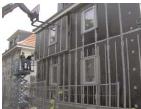
Figur 57. Upphängning av elementen. Källa: http://praxisberichte.eu/hp894/GEDT-Grosselement-Daemmtechnik.htm
