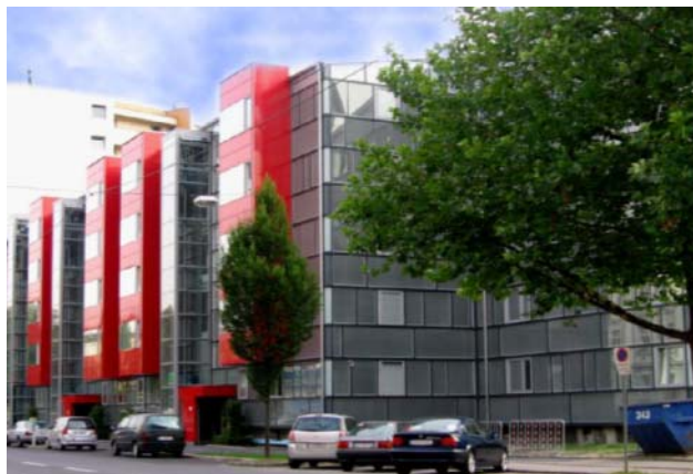
Figur 47. Efter renovering. Källa: Gap-solution.
