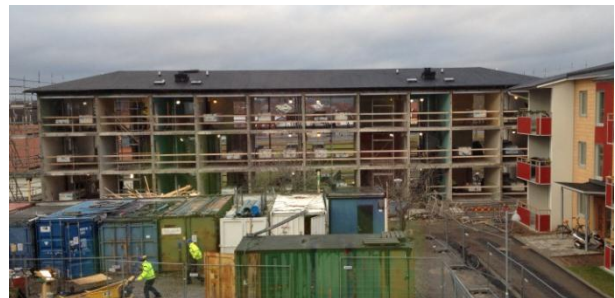
Figur 1 Exempel Hus P, stomme efter rivning
