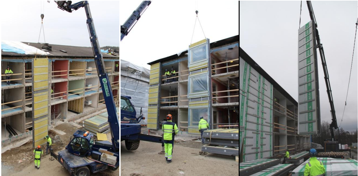
Figur 11 Tv, mitten: De första elementen monteras. I början lastades elementen av på plats och lyftes sen med mobilkran. Montaget effektiviserades sedan genom att en kranbil både levererade och monterade elementen (th).
