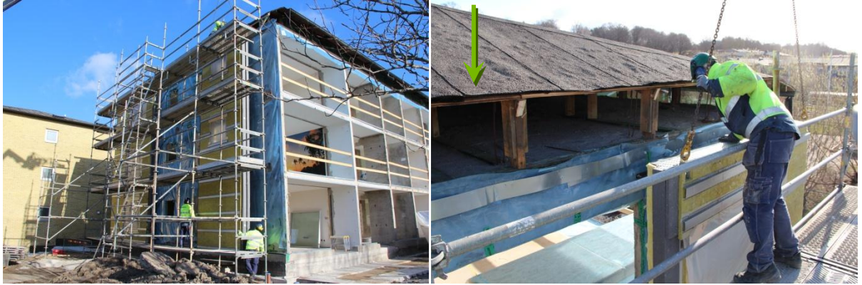
Figur 14 Väggmontage på gavel görs från ställning. Elementen träns in från sidan och sänks ner i de förmonterade fästena (se Figur 12). Eftersom takfoten måste kapas före montage (vid pil i den högra bilden) monterades ett nytt tillfälligt väderskydd över väggen efteråt.
