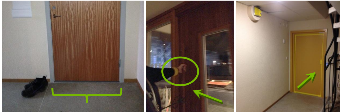
Figur 24 Felkällor: Tv för lägenhetsmätning, dörr utan tröskel. I mitten och th trapphusmätningen: Trapphuset hade utåtgående dörrar som inte kunde låsas, och därför riskerade att öppnas i övertrycksmätningen. I mitten entrédörren som fick hållas fast, och som inte kunde tejpas. Th dörr till källare utan trycke, som dock tejplats.
