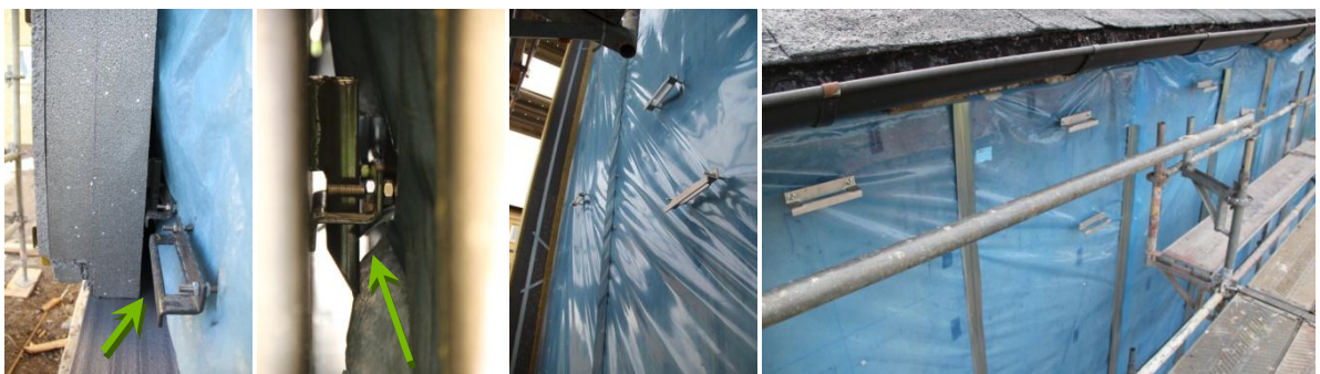
Figur 12 Beslag för montage av element på gavelvägg tv, diffusionsplast och sektionering för lösullsfyllning th.
