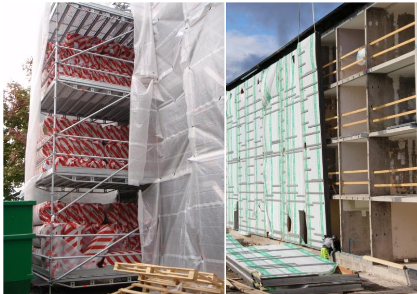
Figur 17 Förr: Material för väggisolering av passivhusprojekt. Nu: väggisolering – och samtidigt stommontage
