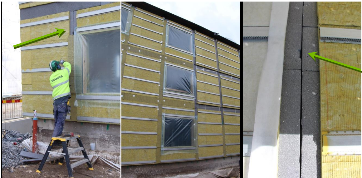
Figur 16 Utvärdig komplettering med skarvrensor på det första huset. I bilden tv har fogskum applicerats för att fylla ut en glipa, därefter en 30mm EPS-skiva över skarven och nu 30mm mineralullsboard. I bilden i mitten syns omfattningen av kompletteringen till tätt hus för Hus N, och hur lite av skarvarna som nåddes från marken (de horisontella banden som kompletteras är dock ingen skarv utan en detalj utformad för montage med truck, vilket sen aldrig användes). Längst th visas skarven mellan ett element med och ett utan vindduk i pilothuset före komplettering. Cellplasten glipar något och det vänstra elementet fick även en lyftskada som behövde lagas i.
