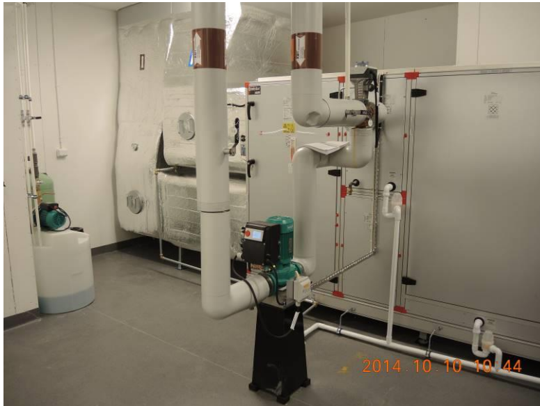
Bild 2.1. Aggregat LB03. I förgrunden syns cirkulationspump KB1-CP11 som hämtar värme från borrhål i berg vilket avges i ett förvärmningsbatteri placerat i utluftskanal före plattvärmväxlare
