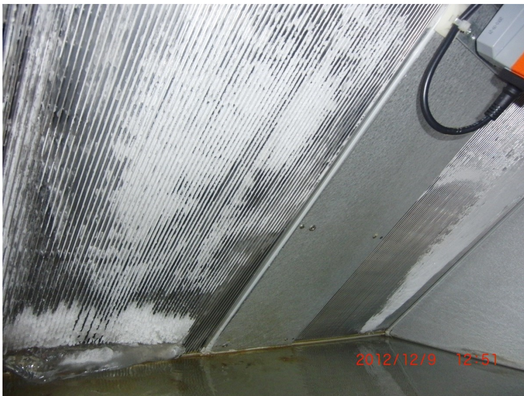
Figur 15 Exempel på batteri med påfrysning i värmeväxlaren, när det är kallt ute och man inte har en förvärmning etc. Bild från Bengt Bergqvist, Energianalys AB.
