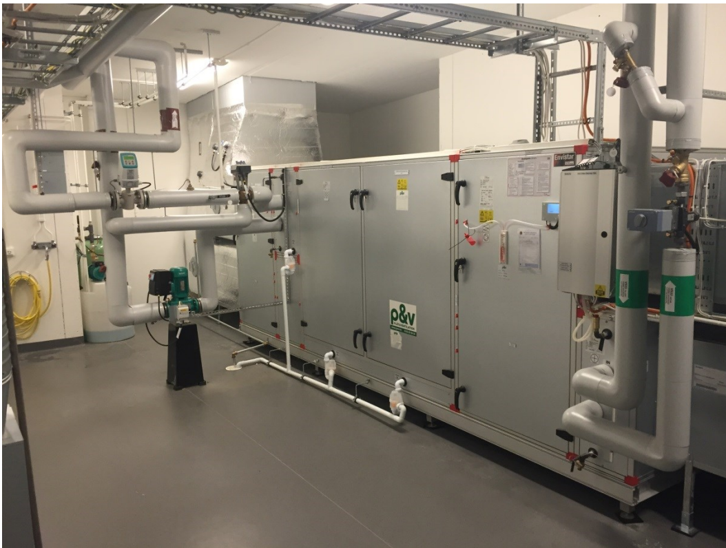
Figur 8 Ventilationsaggregat med HSB-FTX som har nyinstallerad värme- och kylmängdsmätare, som ses till vänster i bilden. Det blev en extrasväng för KB-rören för att erhålla erforderliga raksträckor kring mätaren.
