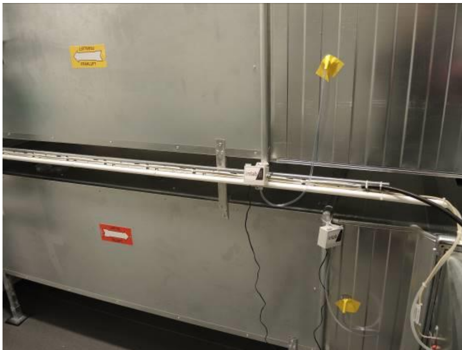
Bild 5.1.9. Loggning av statiskt övertryck i tilluftskanal efter aggregat samt statiskt undertryck i frånluftskanal före aggregat medv trycklogger typ Tinytag.
