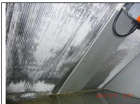
Bild 1.1. Temperaturloggning av aggregat luftbehandlingsaggregat med konventionell plattvärmeväxlare. Under avfrostningsperioder by-passas tilluften förbi värmeväxlaren så att isbildning på värmeväxlarens avluftssida minskas. Under denna tid sänks tilluftstemperaturen och ger då högre uppvärmningsbehov och dragproblem från kall inblåsningluft kan uppstå.
