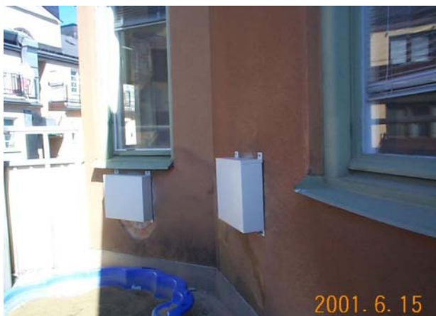
Figur 6.2e Ljudreducerande fasadhuv (prototyp) monterad på tilluftskonvektorer till sovrum o provlägenhet med förslag 1
