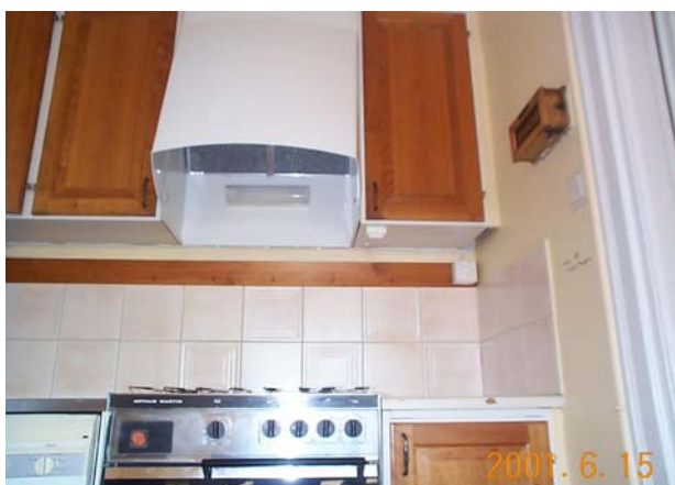
Figur 6.2g Spiskåpa med hög uppfångningsförmåga, provlägenhet med förslag 1.
