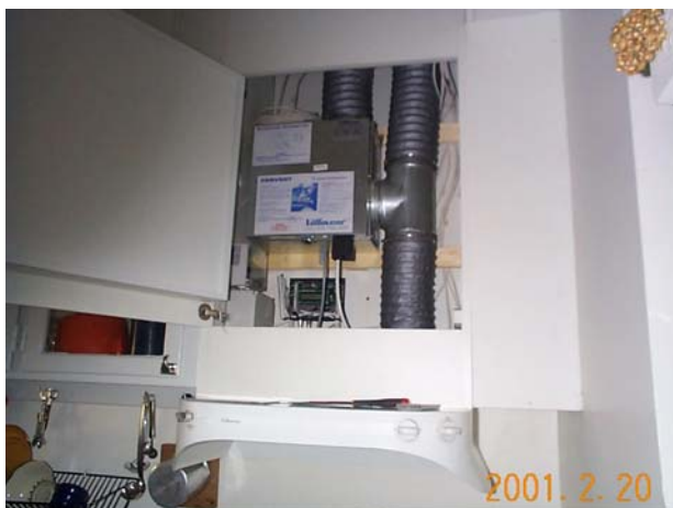
Figur 6.8e Spiskåpa med varvtalsreglerad lägenhetsfläkt i provlägenhet med förslag 5.
