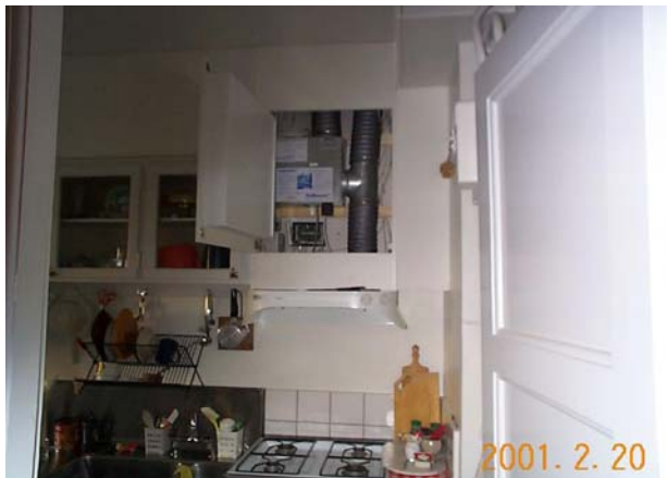
Figur 6.8d Spiskåpa med varvtalsreglerad lägenhetsfläkt i provlägenhet med förslag 5.
