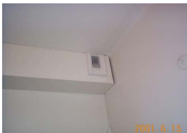
Figur 6.1 Behovsstyrd ventilation enligt förslag 1 i provlägenhet 1. I hallen finns en reglercentral för manuell behovsstyrning. TK1 = liten tilluftskonvektor i sovrum, TK2 = tilluftskonvektor i vardagsrum, FD1 = frånluftsdon med inbyggd fuktstyrning i badrum och wc, FD-kåpa = volymkåpa med timer- och temperaturstyrt spjäll. GTx, GMx och GNx är givare för mätning och utvärdering av lufttemperaturer resp. relativ luftfuktighet resp. CO 2 -koncentrationen.
