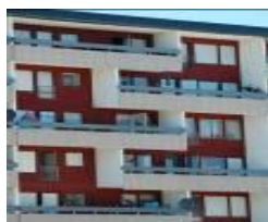
Fasad med betongelement för balkonger.
