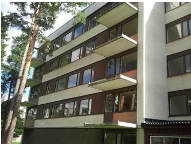
Nya balkonger under byggnad i Sätra
