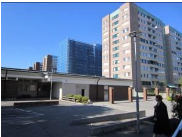
Höghus tilläggsisolerade, putsade. Foto: Sven Fristedt
