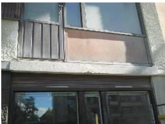
Rester av nedsågad balkong i Sätra
