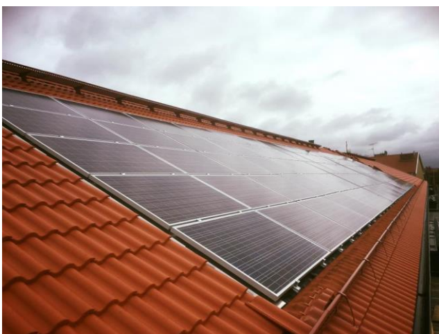
Figur 19: Solcellsanläggningen på en av BRF Krigarens takytor. Foto: Nyedal solenergi.
