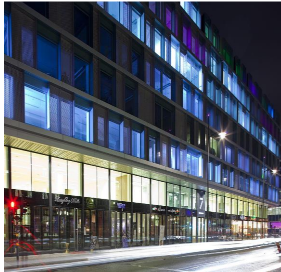
Efter ombyggnad: ca 60-70 kWh/m 2 ,år
