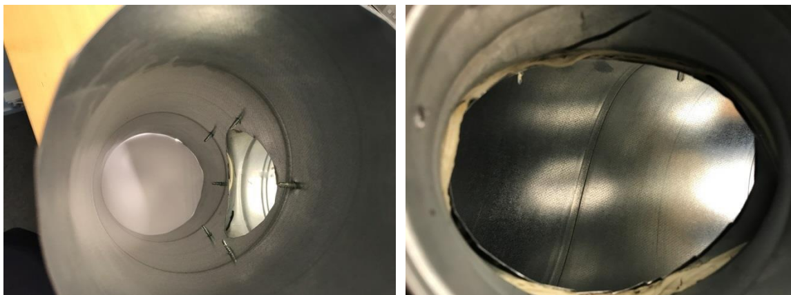
Figur 1 Exempel på inklippt anslutning till tilluftsdon, vilken gav höga ljudnivåer i rum.
