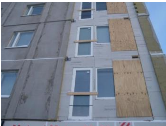
Figur 34. Elementen monterade på fasaden. Foto: Kristina Mjörnell.
