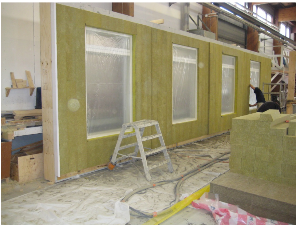
Figur 19. Isolering av fasadelement i fabrik. Foto: VTT.
