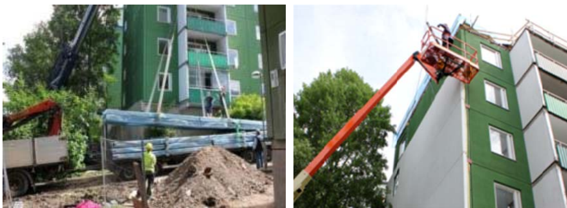
Figur 21. Montage av prefabricerade element skedde med kran.
