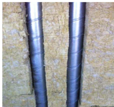
Figur 5. Ventilationskanalerna monterade på den befintliga fasaden och med isolering runt om. Foto: FRONT.
