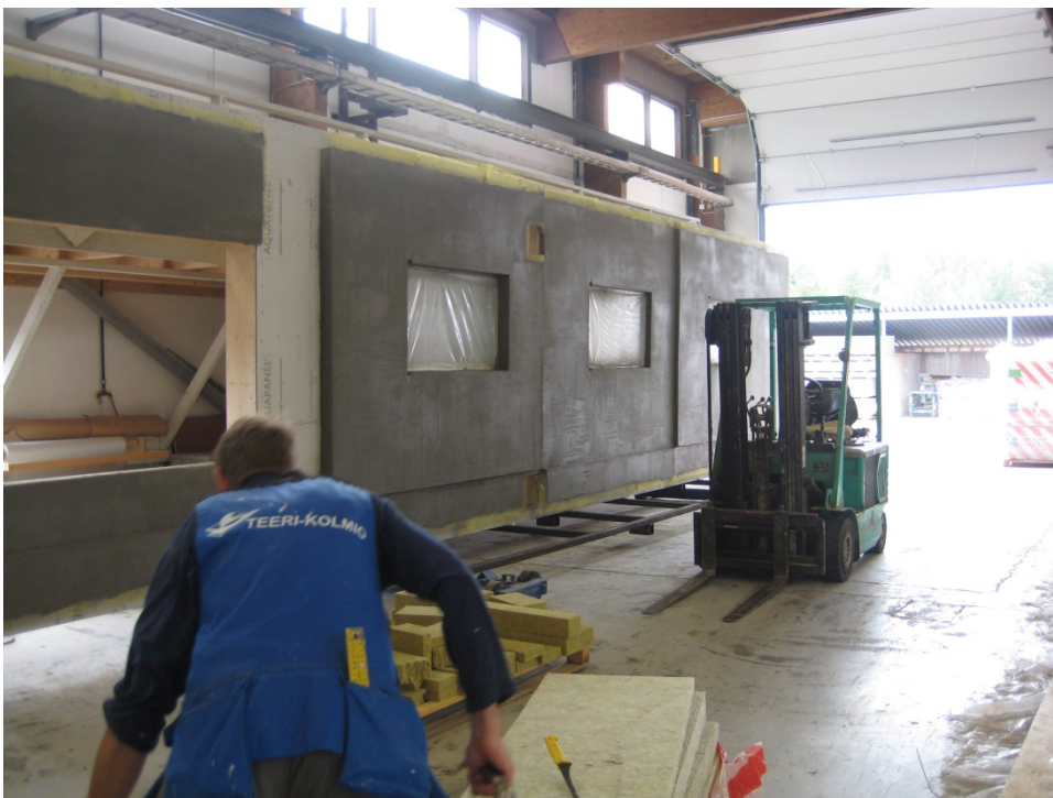
Figur 18. Produktion av fasadelement i fabrik. Foto: VTT.
