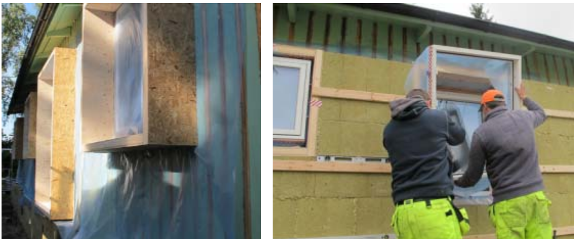
Figur 30. Ny fönsteromfattning av plywood monteras före isolering och själva fönstret monteras efter isoleringen. Foton: Paroc AB.
