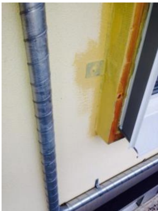
Figur 25. Ventilationskanaler monterades direkt på den befintliga fasaden och utanför dessa monterades isolering och puts. Foton: Front.
