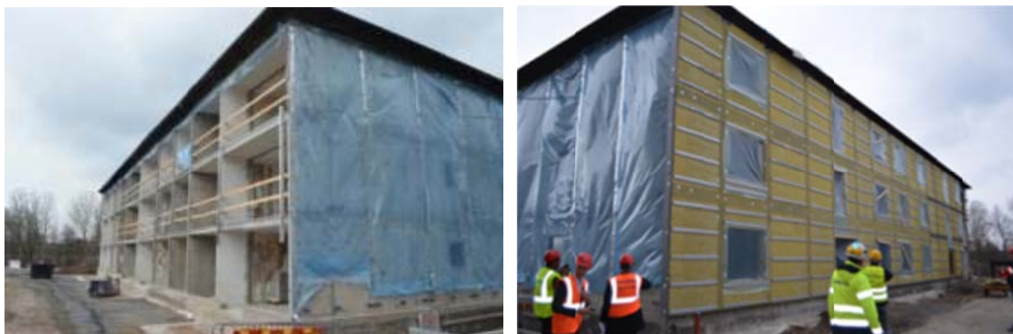
Figur 23. Brogården under montage av prefabricerade väggelement.
