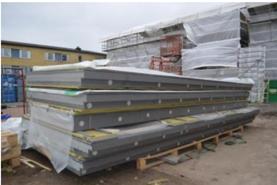
Figur 24. Væggelementen levereras till byggsplatsen och monteras därefter med kran.
