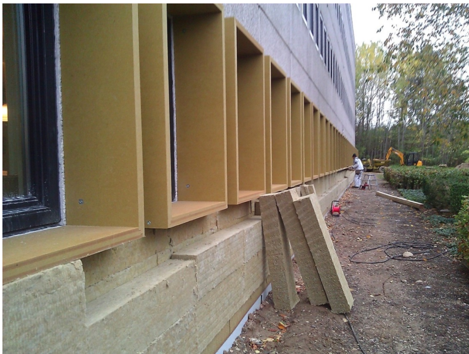
Figur 13. Fönsterram vid tilläggsisolering av kontorsfastighet i Danmark. Foto: Rockwool.
