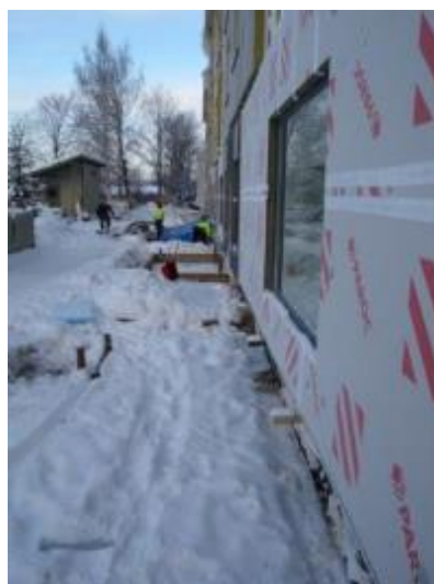
Figur 34. Elementen monterade på fasaden. Foto: Kristina Mjörnell.
