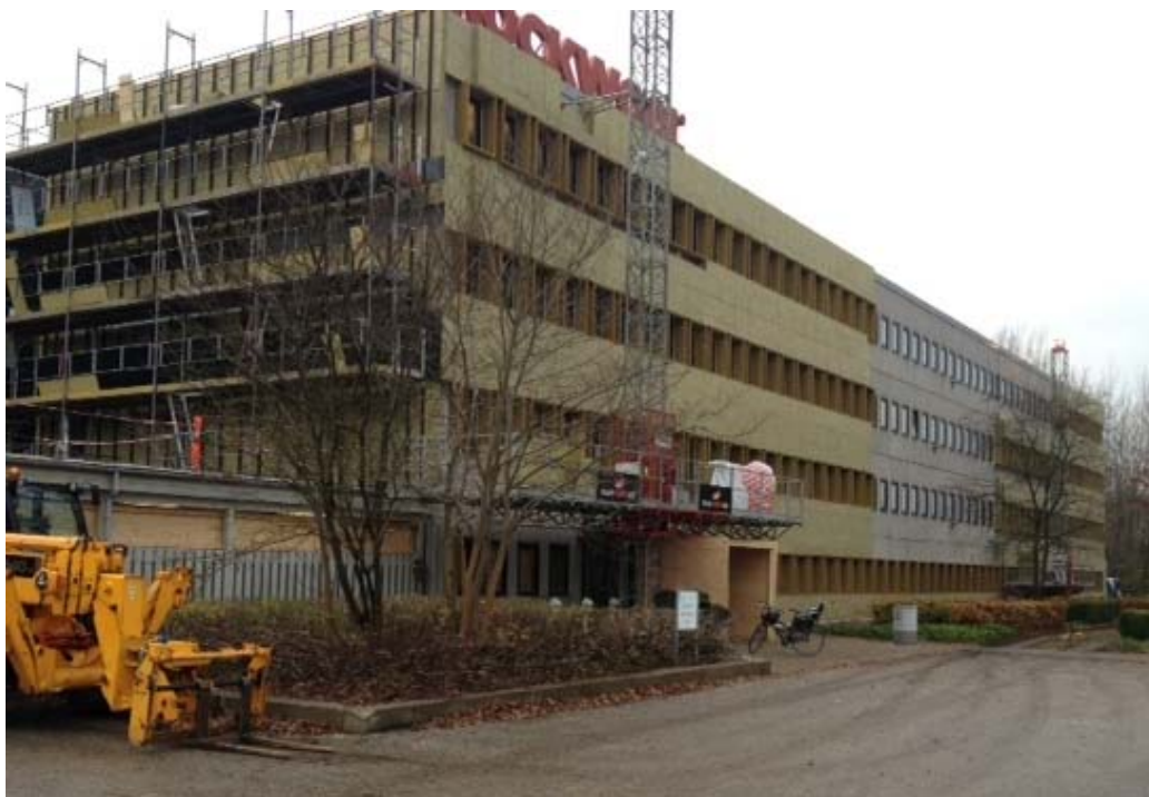
Figur 12. Montering av tilläggsisolering av fasad på kontorsfastighet i Danmark. Foto: Rockwool.
