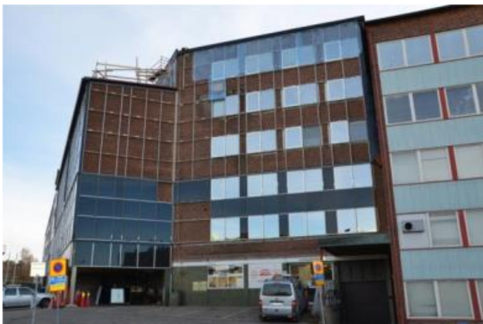
Figur 8. Montage av SAPAs fasadsystem på befintlig tegelfasad. Foto: SAPA.
