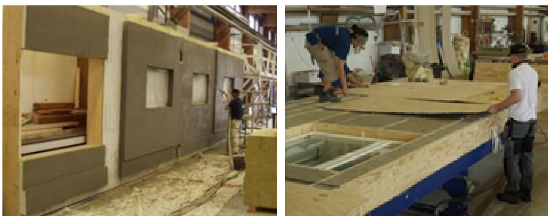
Figur 36. De prefabricerade elementen färdigställs i fabriken.
