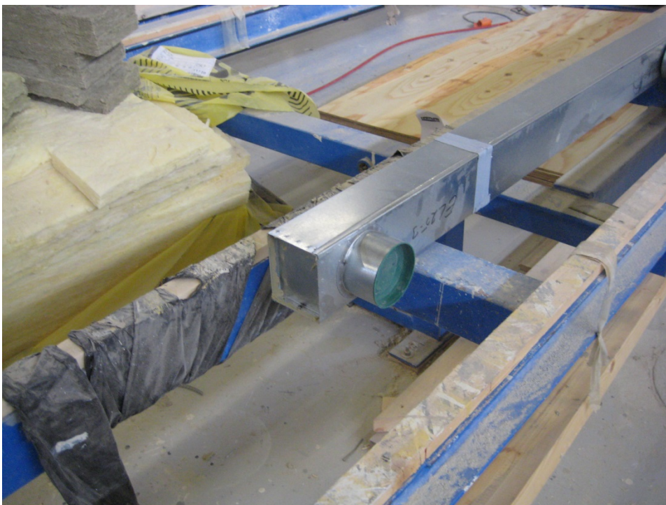
Figur 16. Montering av ventilationskanaler i fasadelementen. Foto: VTT.
