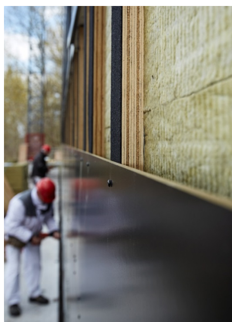
Figur 14. Montering av fasadskiva på läkt vid tilläggsisolering av fasad på en kontorsfastighet i Danmark. Foto: Rockwool.
