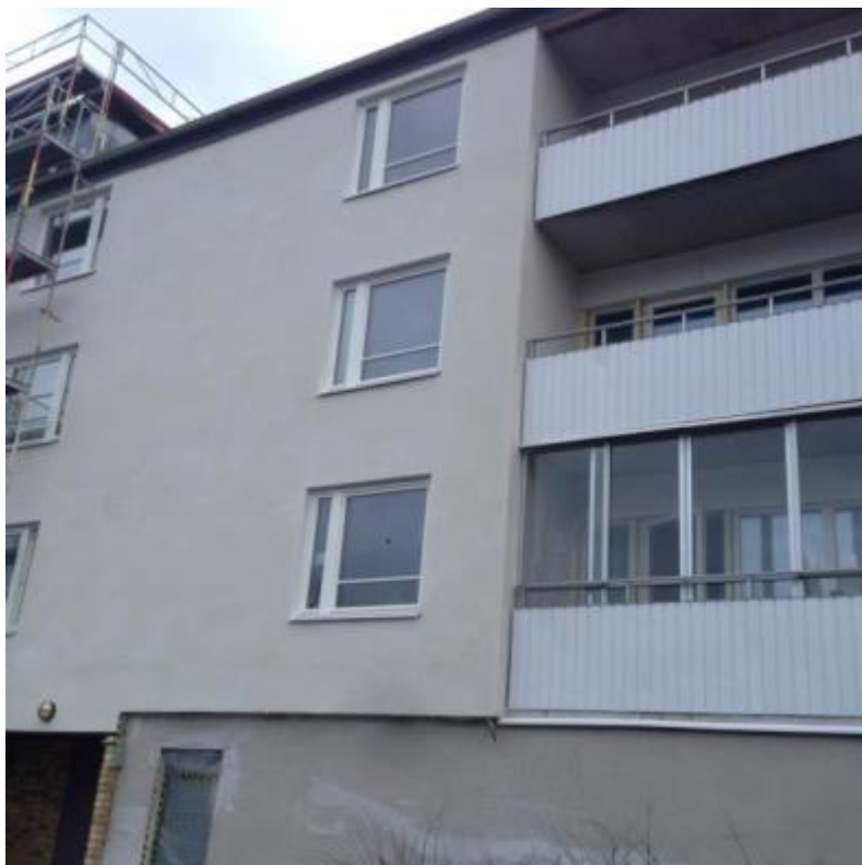
Figur 26. Färdigt utseende på putsad fasad.
