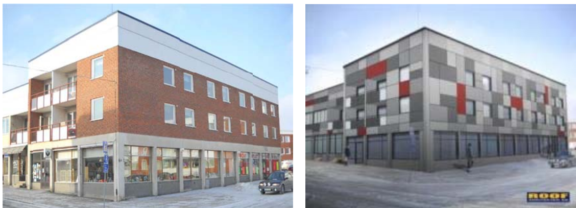
Figur 27. Centrumhuset i Frövi före renovering och projekterat utseende efter renovering. Bilder: Lindesbergshus AB.
