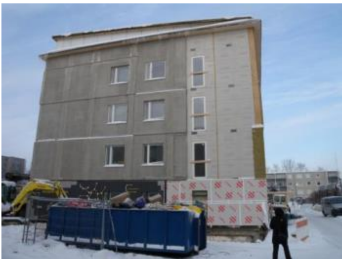
Figur 33. Elementen har en Aquapanel och utan på den en Paroc stenullsskiva som putsas med tjockputs. I bottenplan sitter en Paroc stenullsskiva som vindsydd och en stenskiva som fasadmateriäl. Foto: Kristina Mjörnell.
