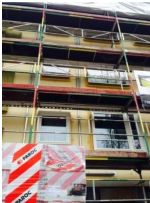
Figur 25. Ventilationskanaler monterades direkt på den befintliga fasaden och utanför dessa monterades isolering och puts. Foton: Front.
