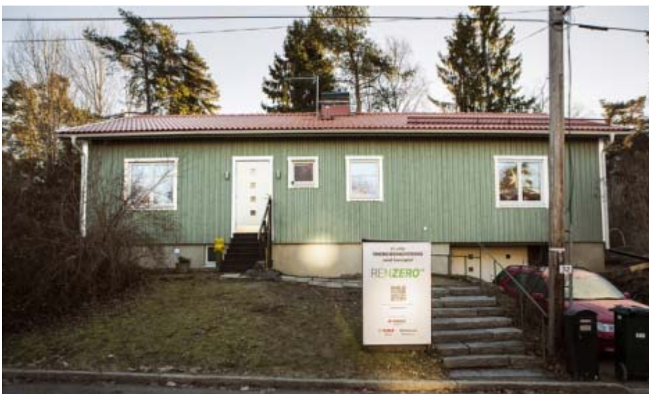
Figur 31. Villan i Skarpnäck efter renovering. Foto: Paroc AB.
