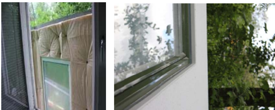
Figur 20. Montage av element sett från insidan samt fönsteranslutning från utsidan.
