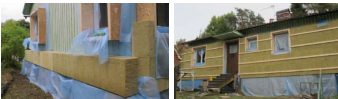
Figur 29. Montage av tilläggsisolering på fasad. Foton: Paroc AB.
