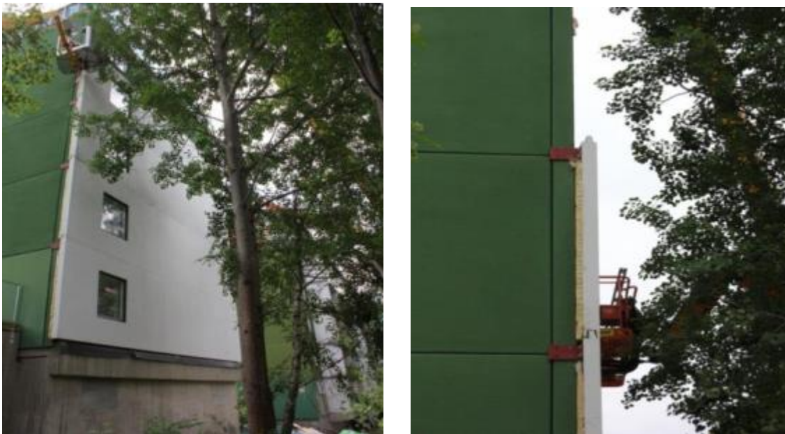
Figur 22. Skarvar mellan elementen kan göras i princip osynliga men anslutning till befintlig fasad kommer att behöva putsas och målas.
