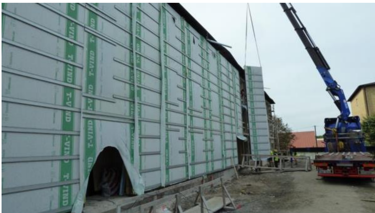
Figur 2. Montage av Elementum eco ABs väggelement på Brogården. Foto Elementum Eco AB.
